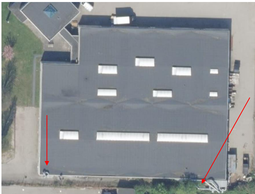
Fig. 5.8. Smedeland 26. De to afkast er markeret med røde pile.
