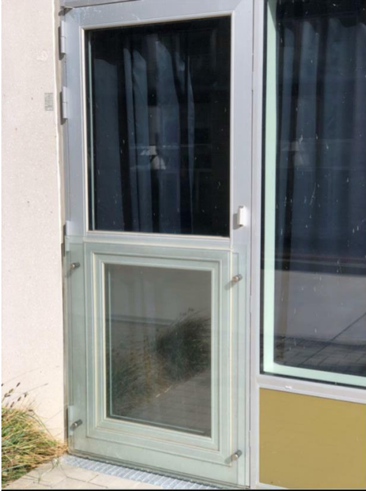
Figur 3.4: Billede af glasværn foran oplukkeligevindue.
