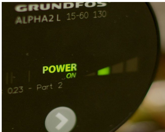
Der har været 'power' på fjernvarmeforsyningen i Albertslund siden 1964.
