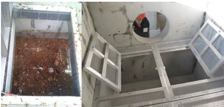
Figur 61. Gallerskärmar separerar skräp och organiskt material.
