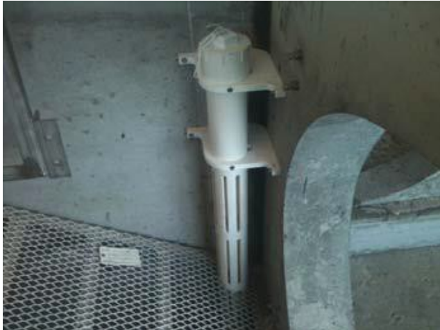
Figur 63. Insats av Vault-Ox för kemisk fällning i magasinet.
