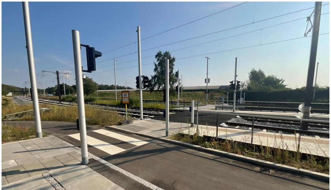
Figur 10. Den nye overgang til letbanestationen og i baggrunden den signalregulerede krydsning af Nordre Ringvej
