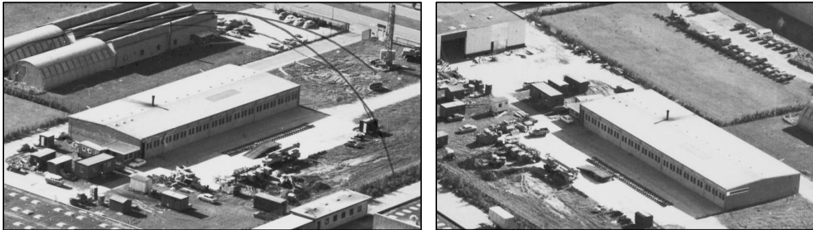
Figur 2 Luftfoto af jernbanespor ved vestlig lagerbygning. Ukendt dato.
